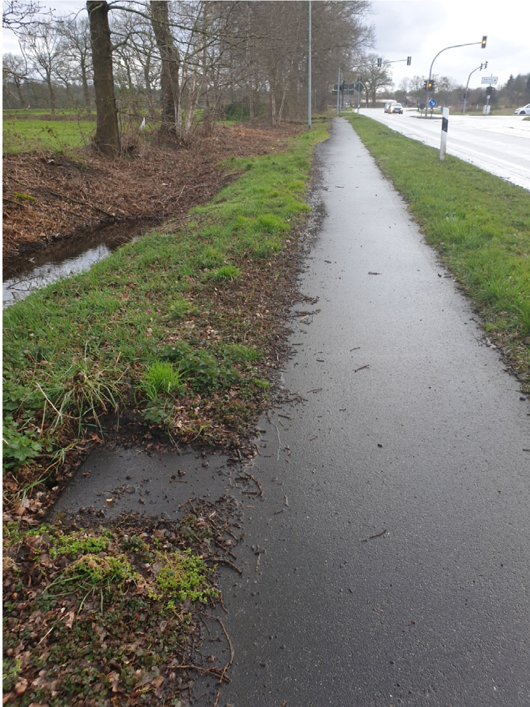
Esenser Straße / B 210 stadteinwärts in Sandhorst
