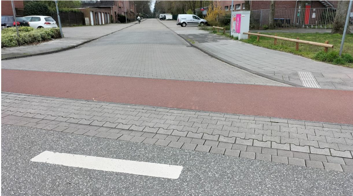
Dies ist vorbildlich für den Radverkehr: Keine Absenkung des Radwegs an Einmündungen und auch keine Absätze. Der Radweg verbleibt auf seiner Ebene und wird gerade über die einmündende Straße geführt. Die Einfärbung ist ein gutes Sicherheitsmerkmal. Abbiegende Kfz von der Hauptstraße müssen die leichte Rampe hoch fahren, was sie zusätzlich auf Radfahrende aufmerksam macht.
